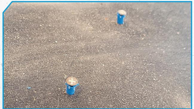
**4** Gracias al **sistema de fusibles VIVION**, al retirar el encofrado los tornillos o clavos utilizados para fijar la caja se desprenden junto con los restos plásticos de los fusibles. Este mecanismo simplifica el proceso, eliminando la necesidad de extraer clavos o tornillos manualmente.
