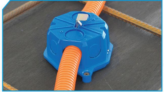
**2** Con los hierros colocados, procede a instalar los caños corrugados utilizando las múltiples y mejoradas entradas de las cajas de centro VIVION. Este diseño optimizado facilita el montaje, asegura un ajuste perfecto y mejora la resistencia durante el llenado de la loza.
